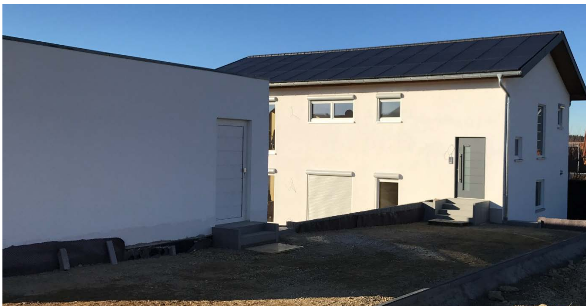
Abbildung 5: Außenansicht Gebäude 1. Vorne links: Garage mit Elektroinstallation. Hinten rechts: Wohngebäude mit PV-Anlage
